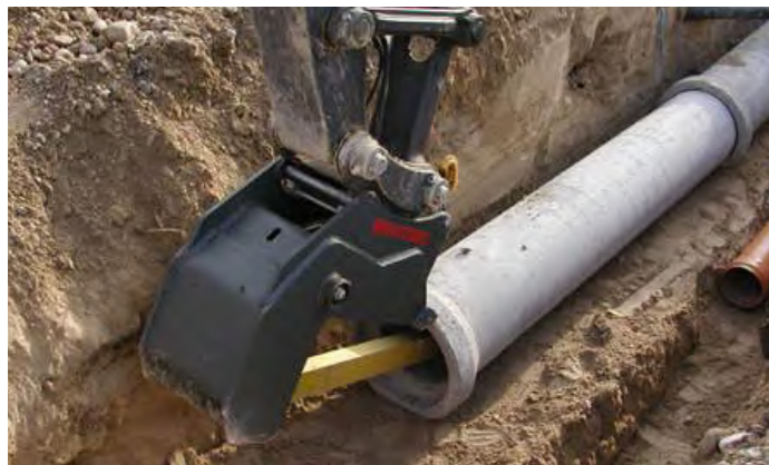
Speedypipe Rohrverlegung
