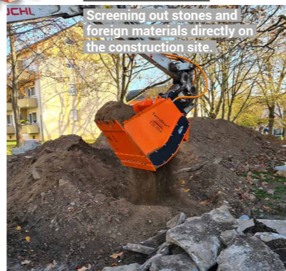
Aussieben von Steinen und Fremdstoffen direkt auf der Baustelle.
